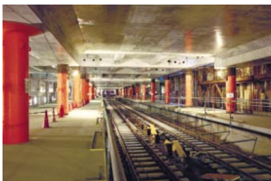
武蔵小山駅の地下化工事の様子
