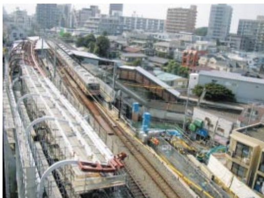
旗の台駅の改良工事の様子
